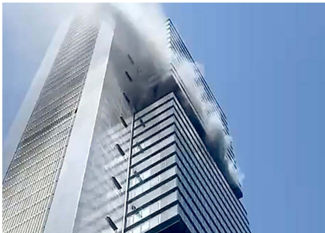
Las medidas de protección del edificio evitaron una catástrofe mayor. EFE
