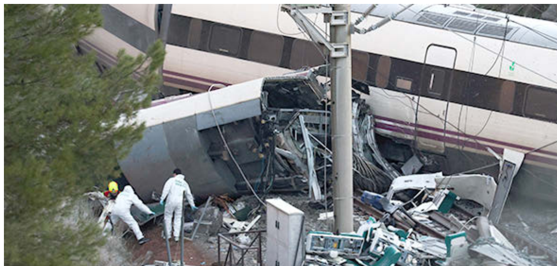
El tren Alvia Madrid-Huelva sufrió graves daños al salirse de la vía. Reuters
